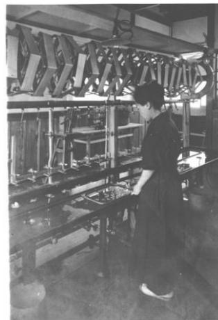
図 18 は、純水館茅ヶ崎製糸所に設置された御法川繰糸機である。立繰（立って繰糸）式、多条（緒が10以上）式の特徴がわかる写真である。
